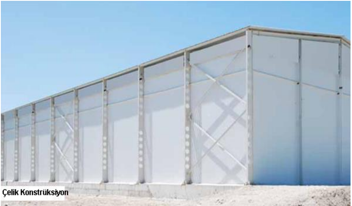
Şekil 7.2: Çelik Konstrüksiyon Fabrika Uygulaması
