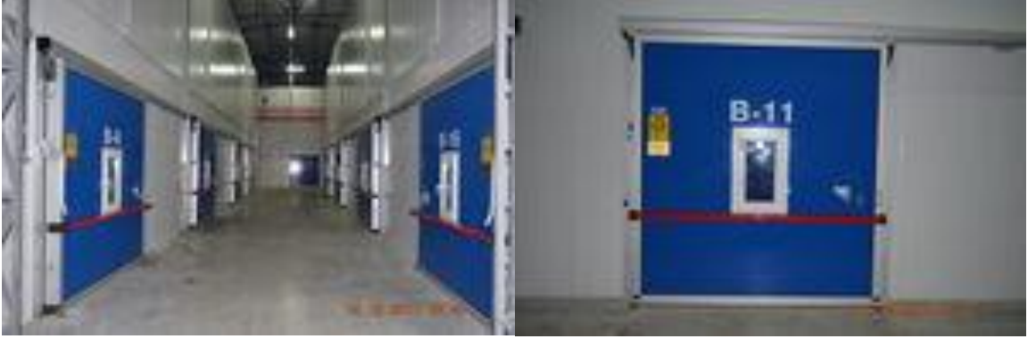
Şekil 4.10: Sürgülü Tip Pencereless Soğuk Depo Kapıları:
