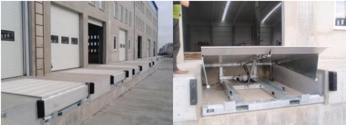
Şekil 4.14: Hidrolik Rampa
