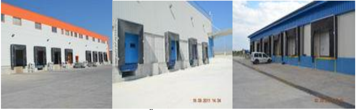
Şekil 4.15: Yükleme Körüğü Örnekleri.
