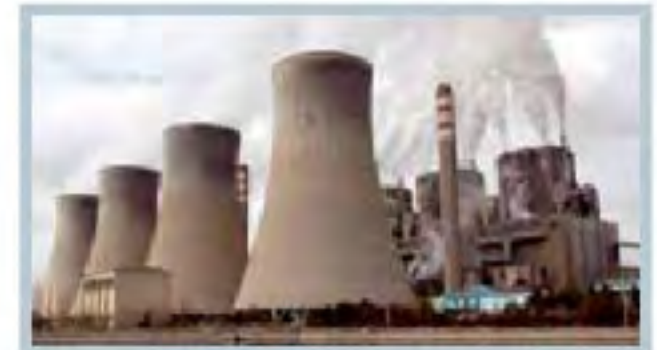
Bölgemize Bir Bakış Afşin-Elbistan Termik Santrali
