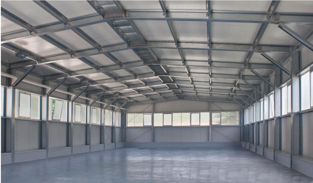
Şekil 4.16 Çelik Konstrüksiyon Fabrika Uygulaması
