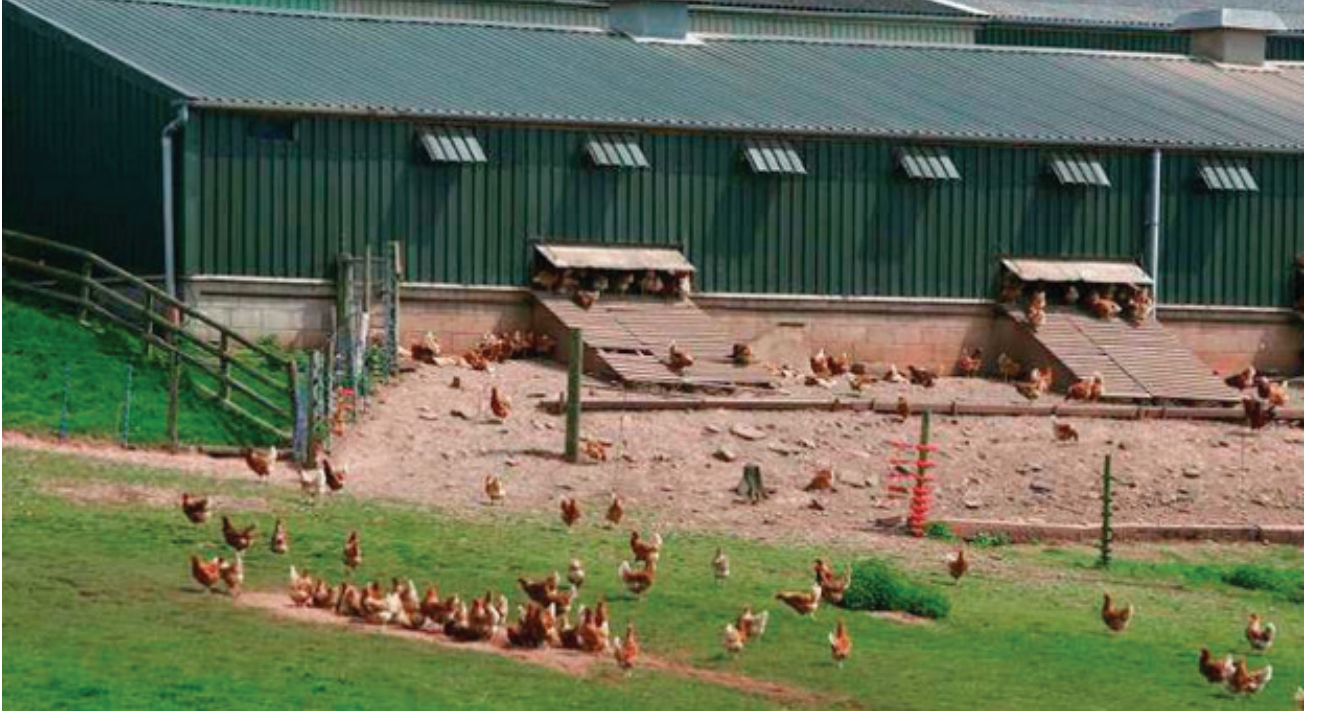
Şekil 32. Panel malzeme ile yapılmış bir kümes
