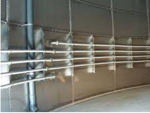
Fotoğraf 1 Çürütücü ısı değiştirici boruları
