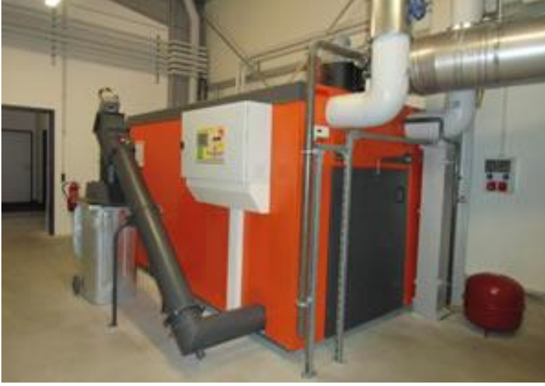
Fotoğraf 3 Heizomat RHK – AK serisi biyokütle doğrudan yakma ünitesi
