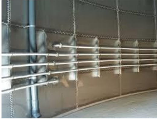
Fotoğraf 1 Çürütücü ısı değiştirici boruları
