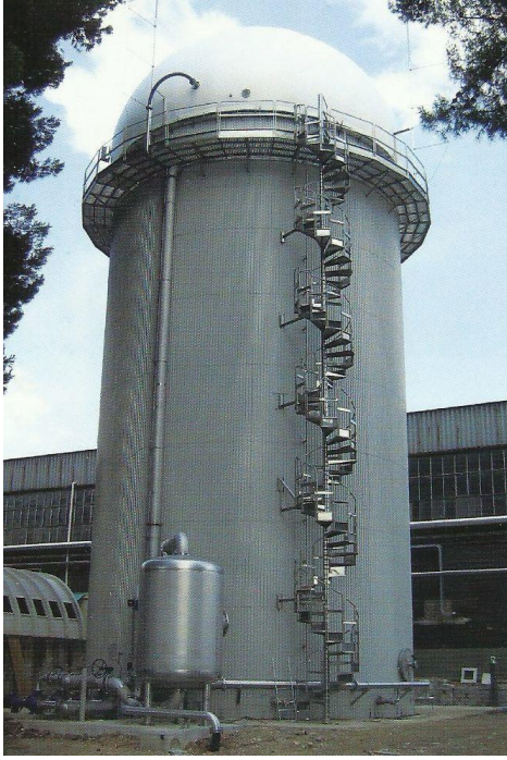
Fotoğraf 5 Biyogaz çürütücü tankı ve üzerinde yarın küre formunda biyogaz depolama ünitesi
