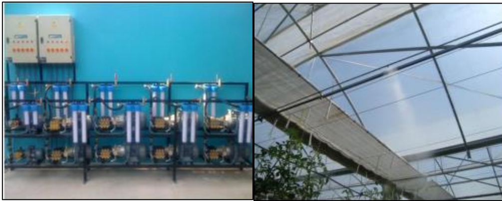
Şekil 8.31 Yüksek Basınçlı Sisleme Sistemi [7]
