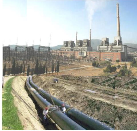
Şekil 8.14. Örnek bir bölgesel ısıtma sistemi boru hattı
