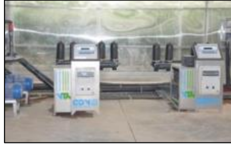
Şekil 8.27 Sera Sulama ve Gübreleme Otomasyon Cihazları [7]
