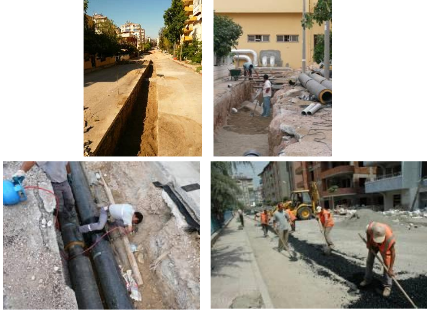
Şekil 8.15. Kanalların Kazılması, Boruların Döşenmesi ve Montajı
