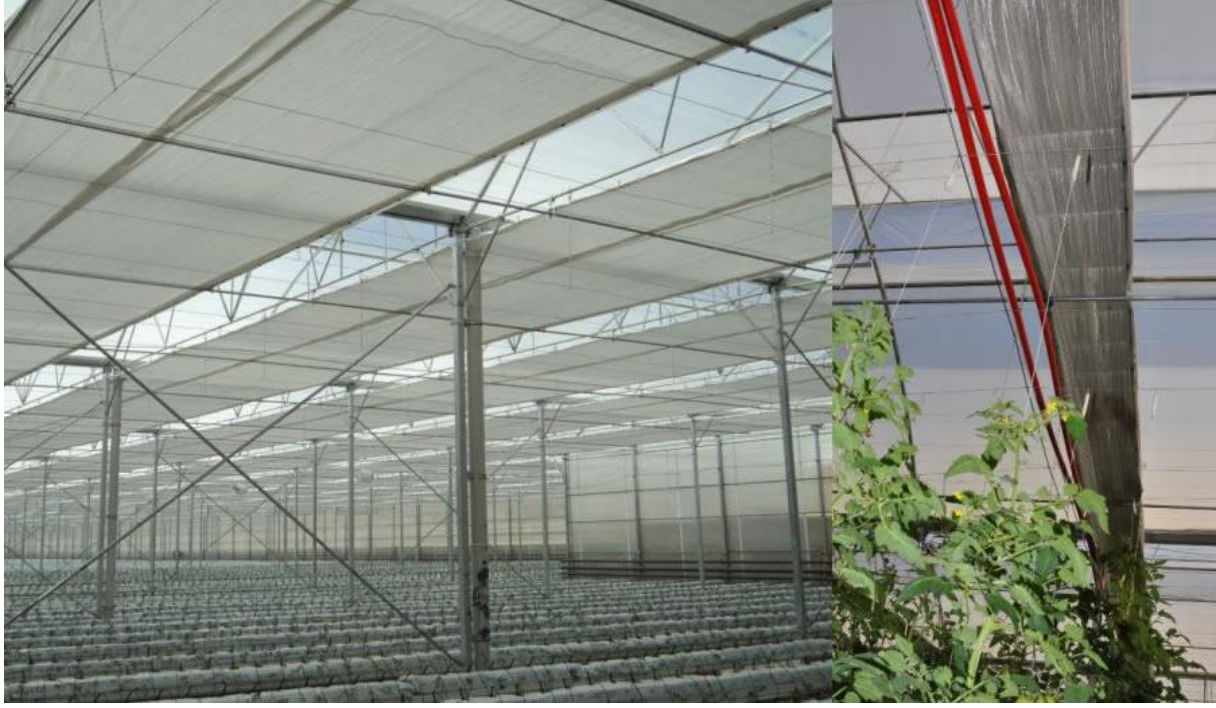
Şekil 7.13. Isı Perdesi Açık ve Kapalı Hali
