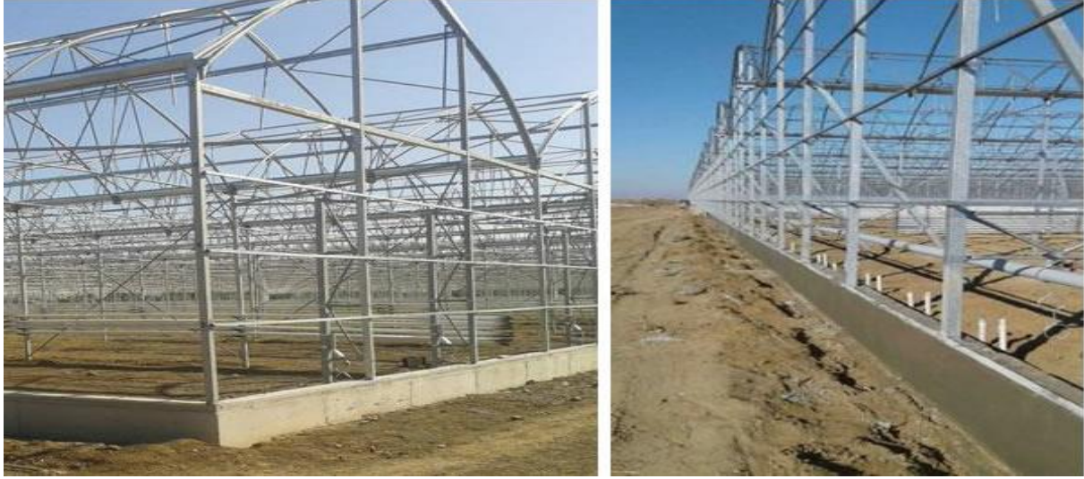
Şekil 7.5. Çevre Temel ve Yan Perde Betonlu
