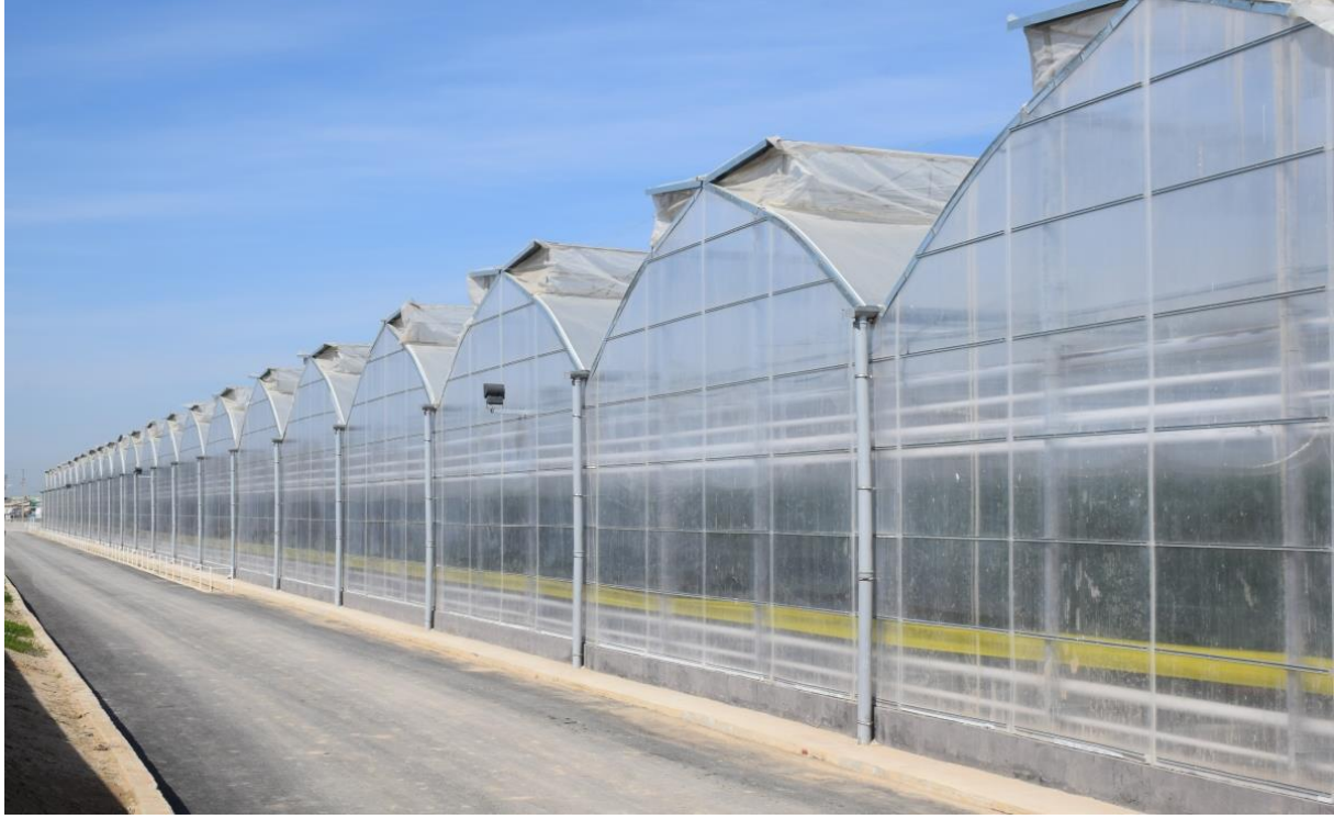
Şekil 7.12. Polikarbon Sera Yan Duvarları
