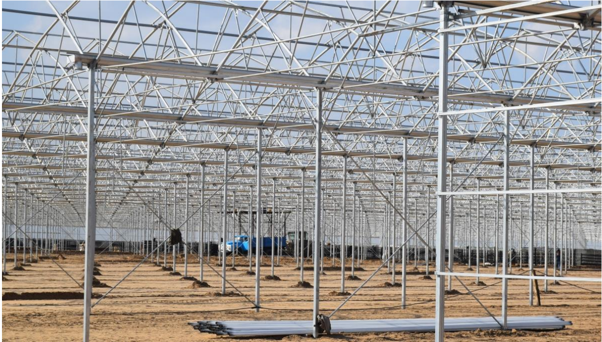
Şekil 7.10. Sera Çelik Konstrüksiyon Elemanları
