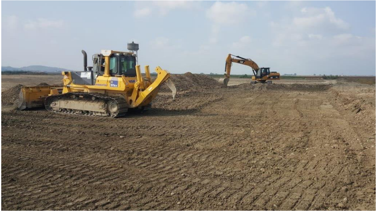
Şekil 7.2. Sera Alanı Arazi Tesviyesi
