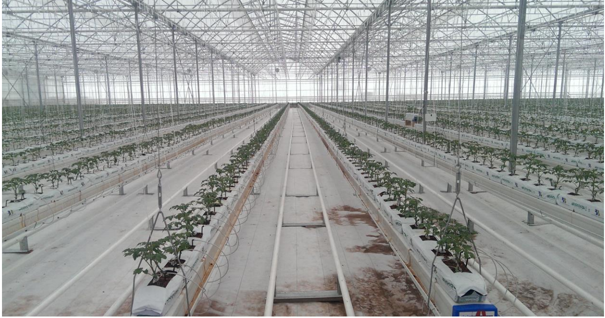
Resim 7.15. Bitki Yetiştirme Yatağı (Askılı Sistem)
